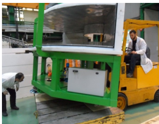
La nouvelle protection du détecteur 7C2 en route vers son emplacement définitif dans les Hall Réacteur.
